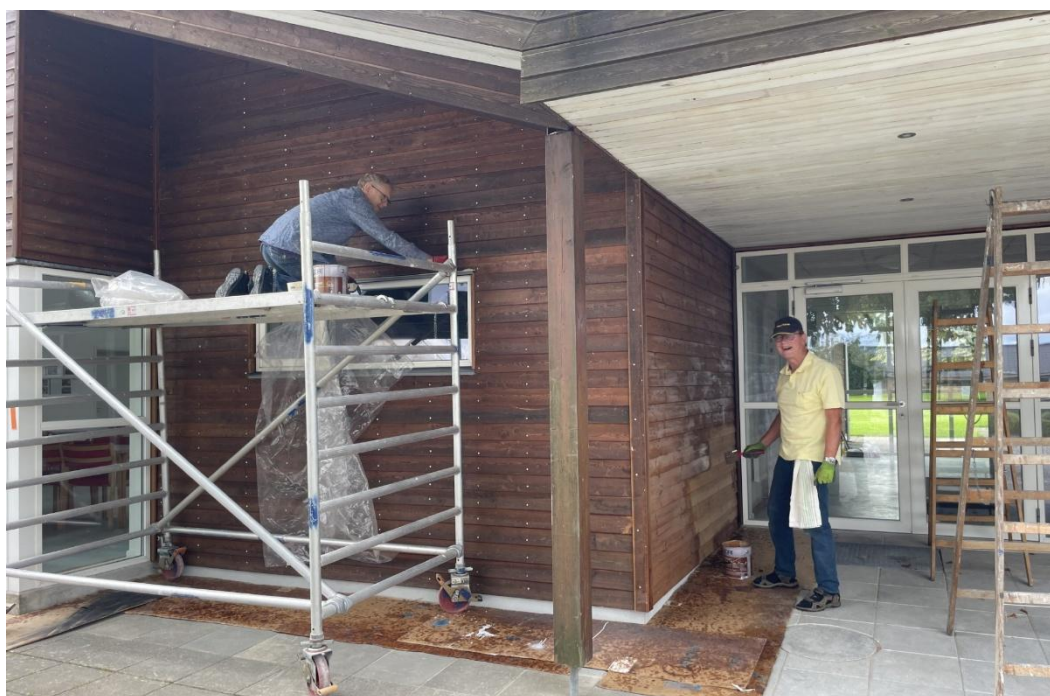
Arbejdet med det nye køkken i fuld gang
